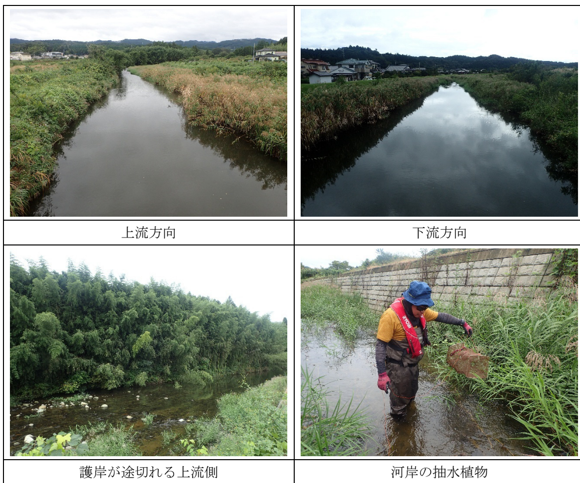
図 6.2-12 河川の状況（福井橋）
