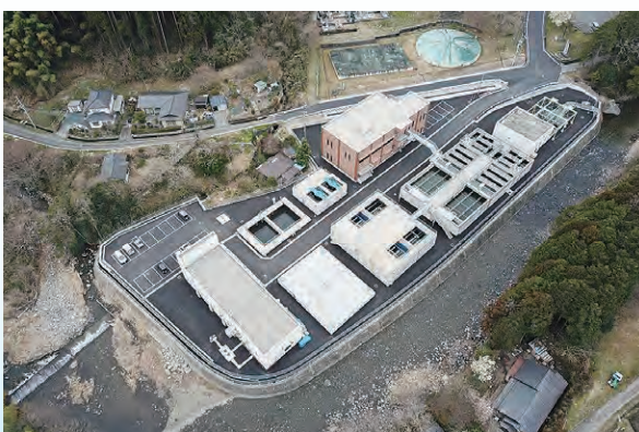
華川浄水場 令和3年10月供用開始
