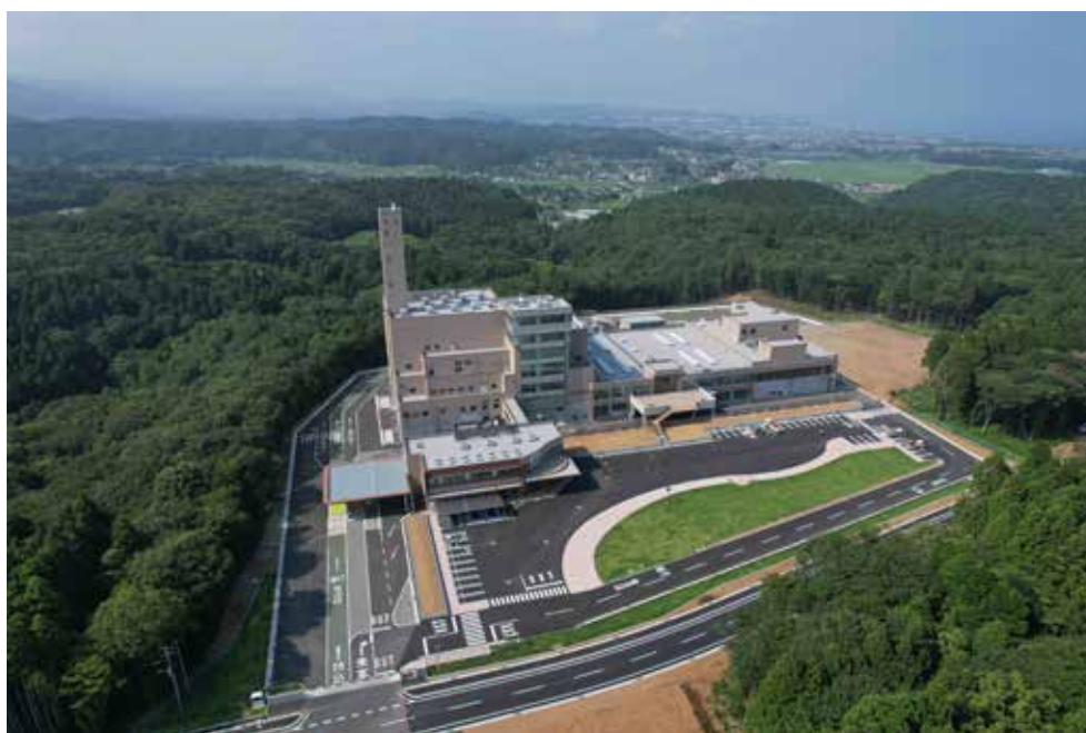
高北清掃センター（ドローンによる撮影）
