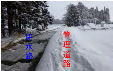
積雪により、管理道路と用水路の境界がわかりにくい状況
