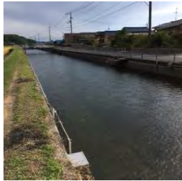
10月初旬の水路の様子。 水路幅が広く、通年で水量が多い。
