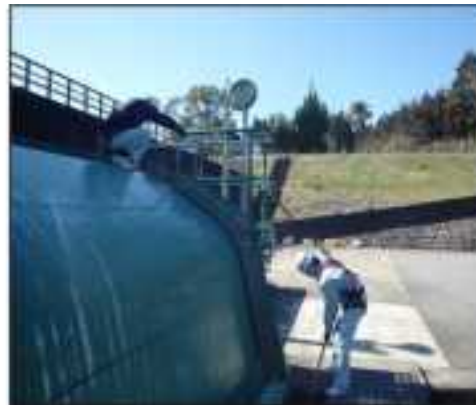
複数の作業従事者による点検・管理作業の実施
