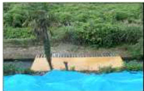
水路への仮蓋の設置
