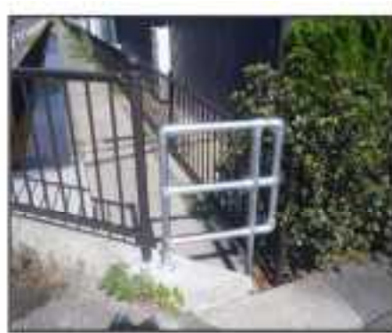
侵入防止柵を設置 (新潟県新潟市)
