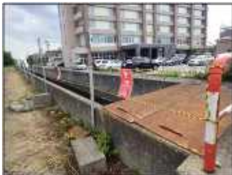
応急ロープの設置
