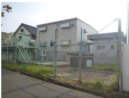
【駅東排水ポンプ場（河川の逆流防止）】
