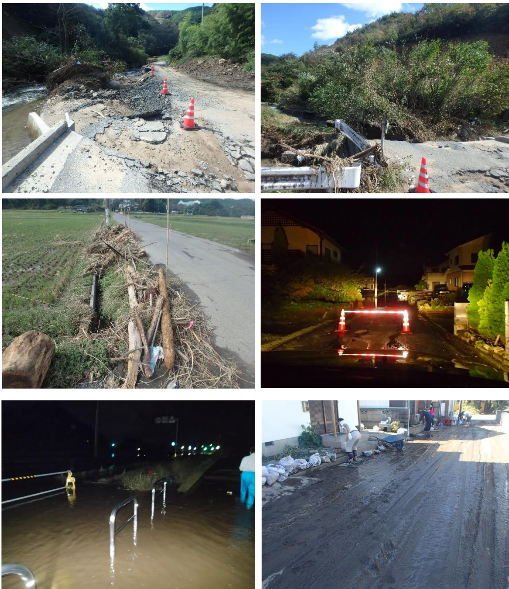
<市内の被害の写真 崖・道路崩落、道路の冠水>
