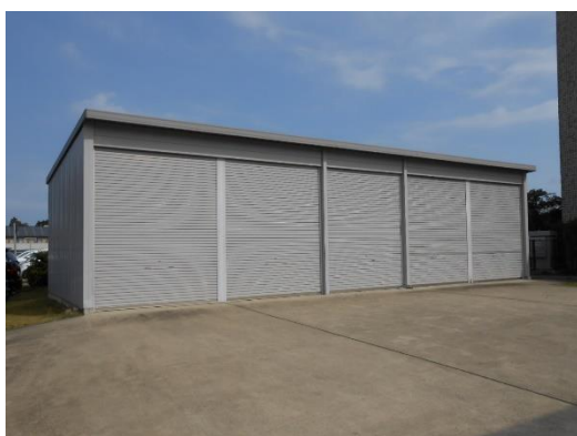
【市庁舎防災資材倉庫（土嚢等の備蓄）】
