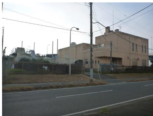
【駅西排水ポンプ場（河川の逆流防止）】
