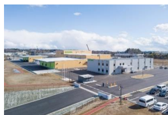
構内・室内の照明はすべて LED を使用しています
