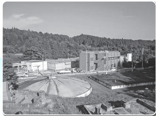
▲華川浄水場の全景
