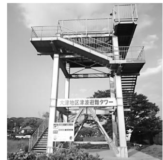
大津地区津波避難タワー
