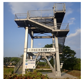
大津地区津波避難タワー
