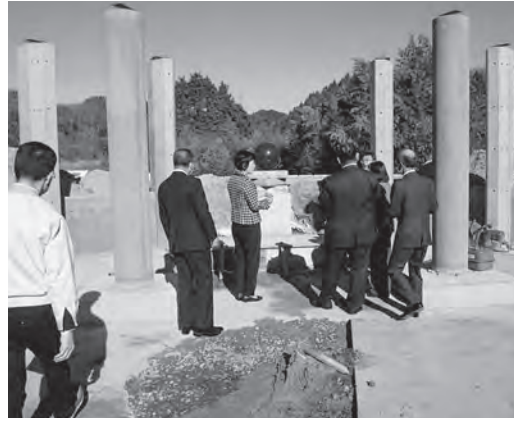
泉沢霊園内に建設中の合葬墓地 (関本町)
