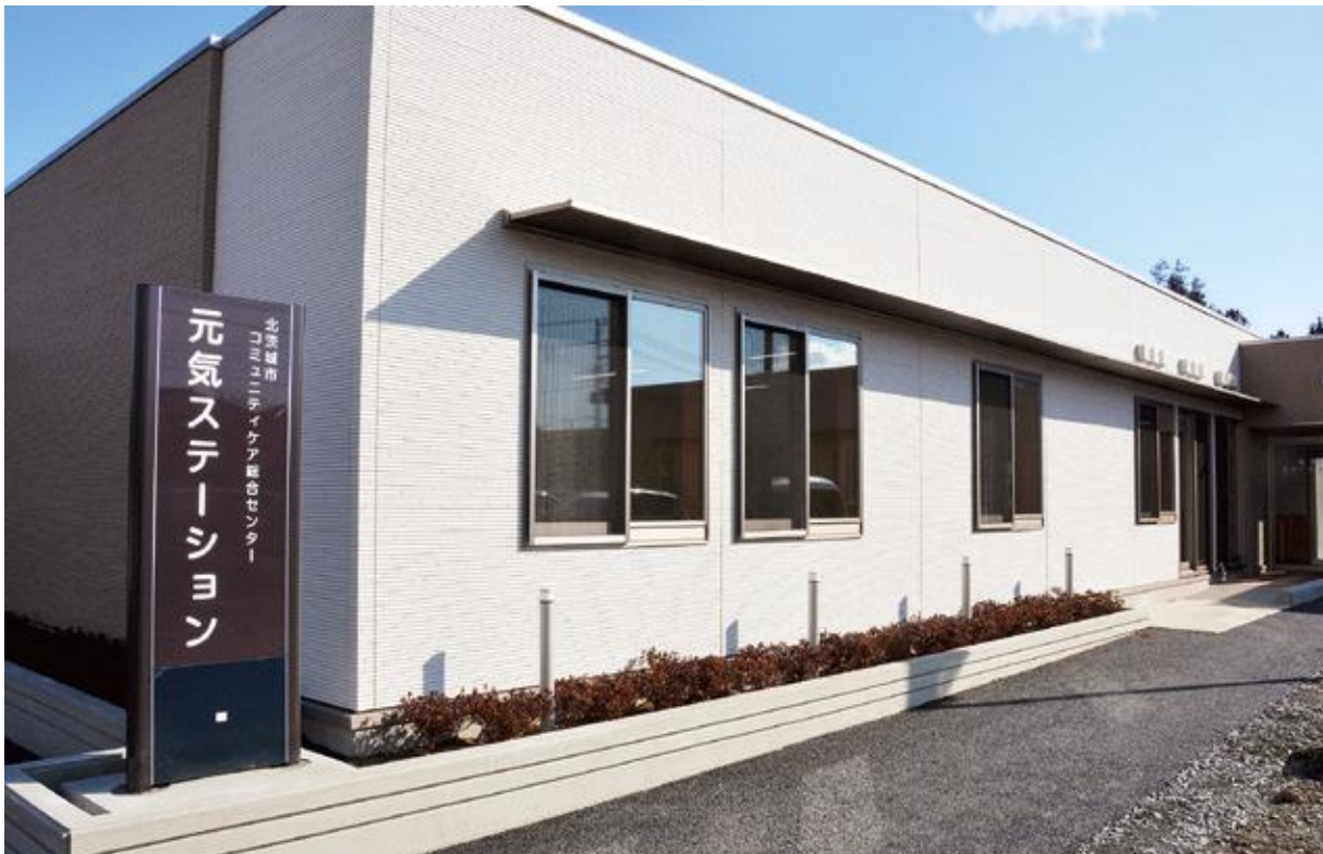
コミュニティケア総合センター(元氣ステーション)
