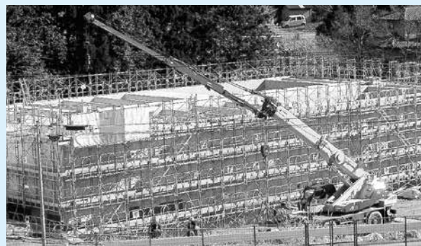
華川浄水場の更新
