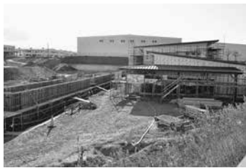
建設が進むクラブハウス
