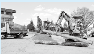
北茨城市建設業親交会による 道路復旧・障害物除去訓練
