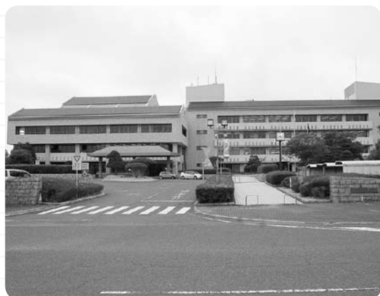
北茨城市役所
