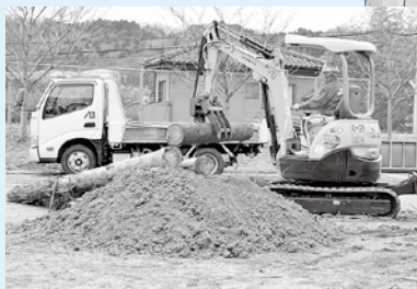
▲北茨城市建設業親交会による道路復旧・障害物除去訓練
