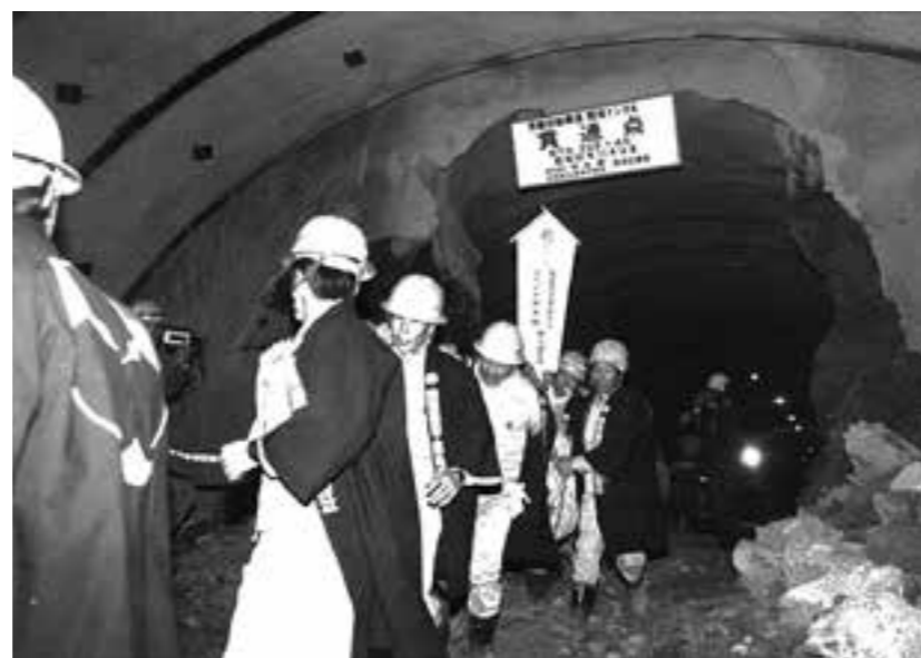
工事が進められてきた常磐道関南トンネルが貫通 (昭和61年)
