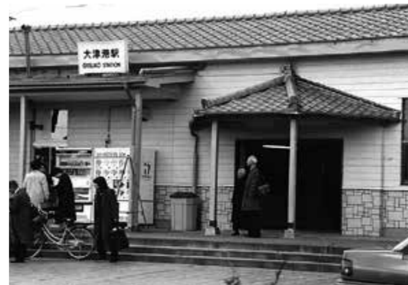
六角堂をイメージして改修された大津港駅舎 (平成2年)
