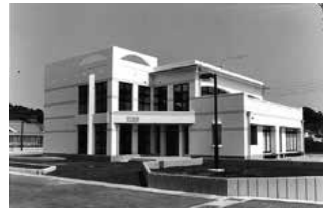
大津漁村センター「ポートオオツ」が完成 (平成2年)
