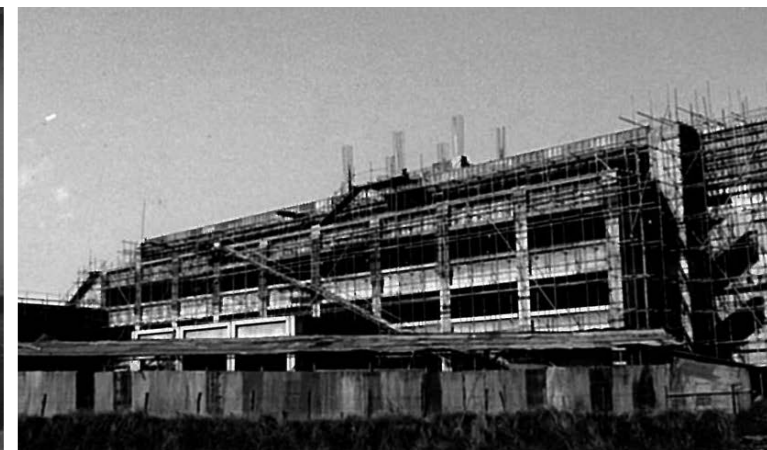
建設が進む北茨城市立病院（昭和46年）
