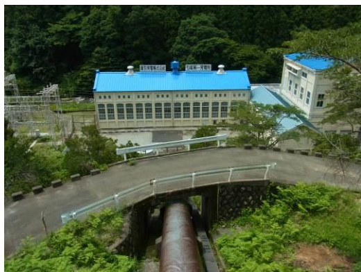
石岡第一発電所（国指定文化財）
