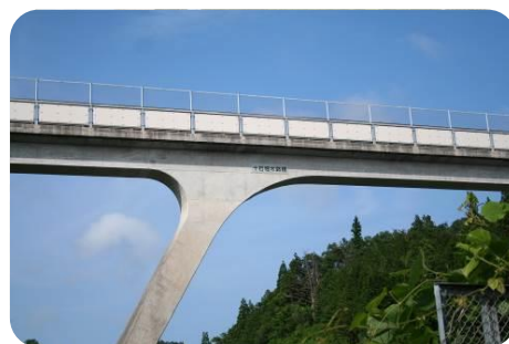
十石堀水路橋
