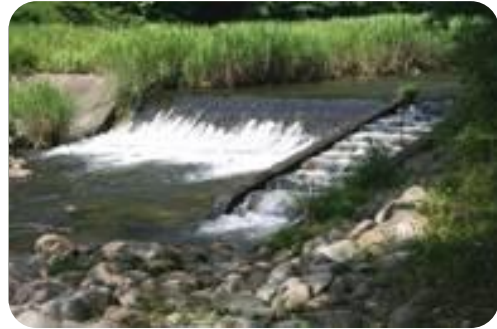
花園川：取水堰（華川小学校傍の堰）
