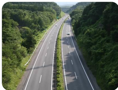
常磐自動車道 十石堀水路橋より東京方面
