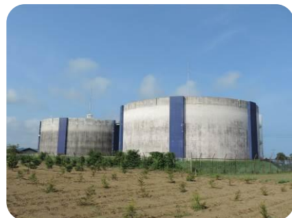
松井配水タンク
